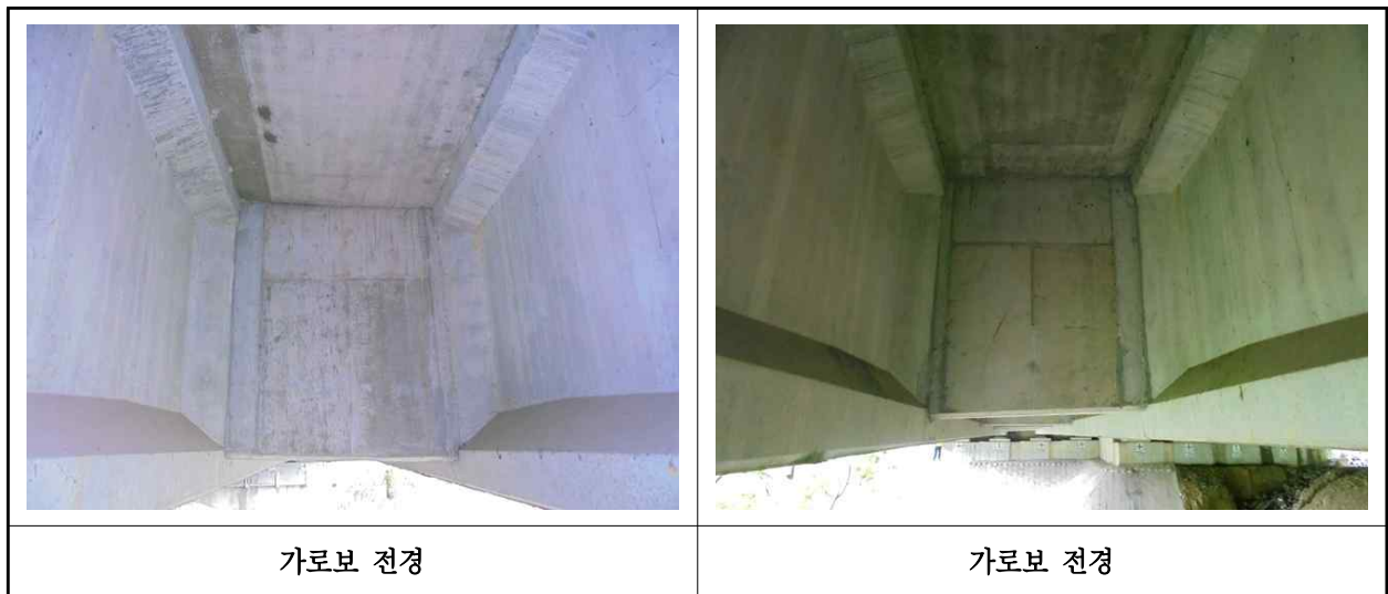
【사진 1.3.6】 가로보 전경
