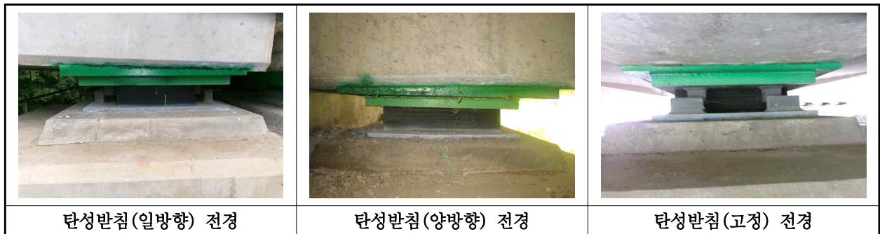
【사진 1.3.12】 교량받침 전경
