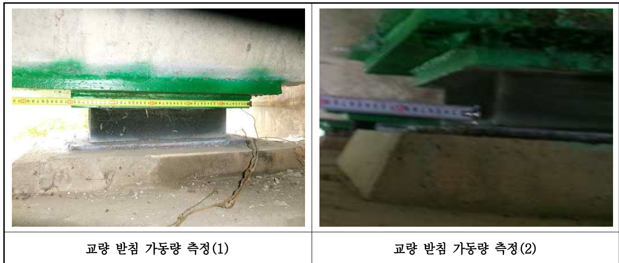
【사진 1.3.15】 교량받침 이동량 측정
