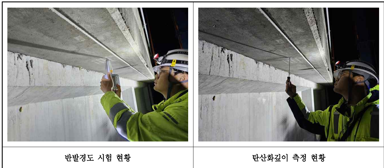
【사진 1.4.1】 콘크리트 내구성조사 현황
