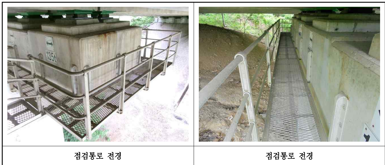
【사진 1.3.25】 교량 점검시설 전경
