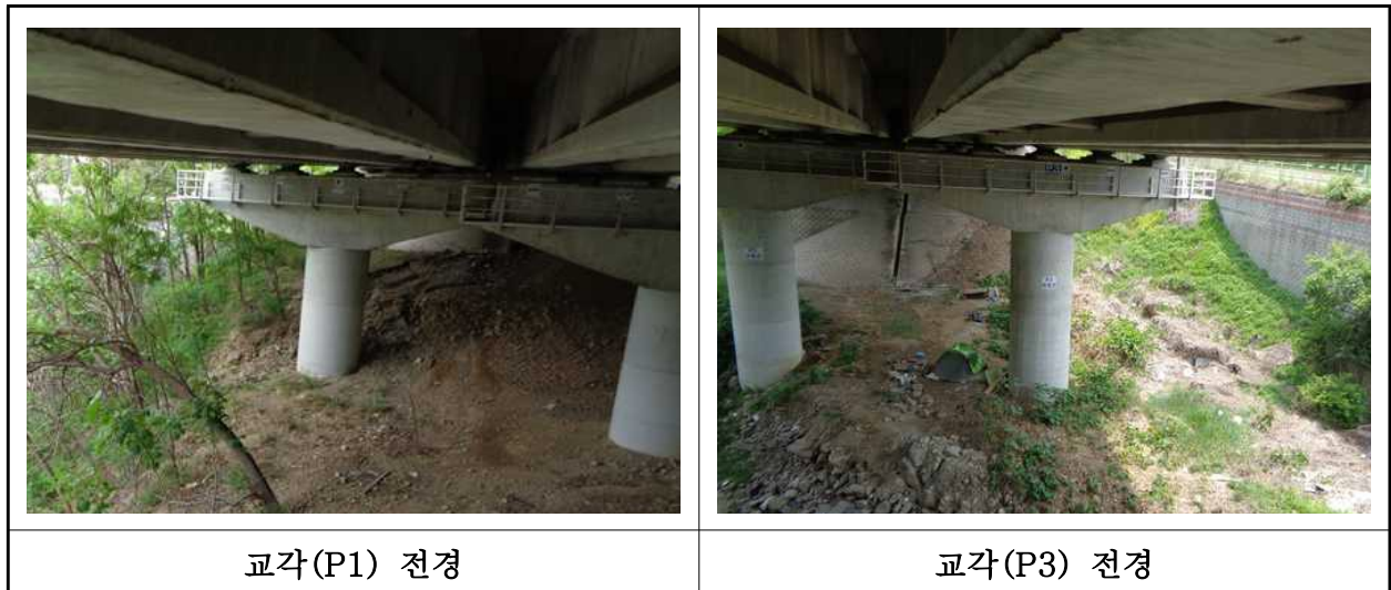
【사진 1.3.10】 교각 전경
