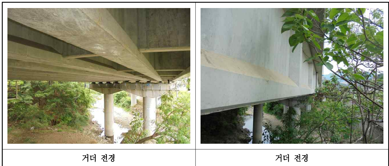
【사진 1.3.4】 거더 전경
