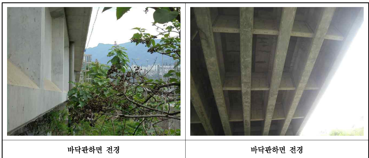
【사진 1.3.2】 바닥판하면 전경
