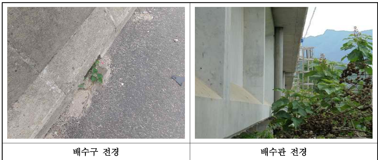
【사진 1.3.21】 배수시설 전경
