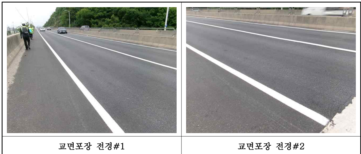
【사진 1.3.19】 교면포장 전경
