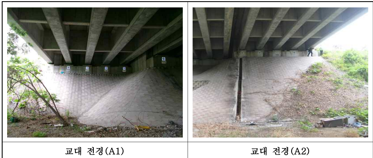
【사진 1.3.8】 교대 전경
